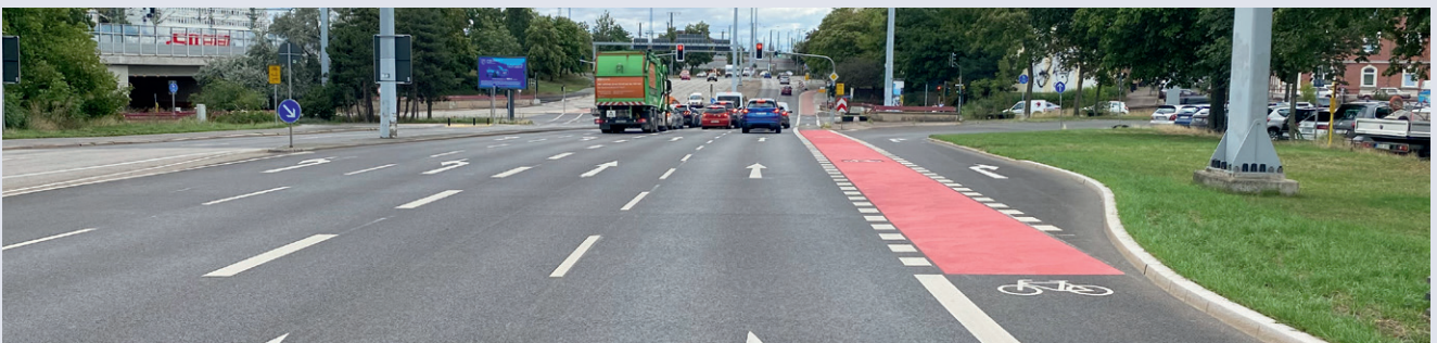
Ohne bauliche Erweiterung der Verkehrsfläche konnte ein sicherer Radfahrstreifen im Knotenpunkt angelegt werden.
