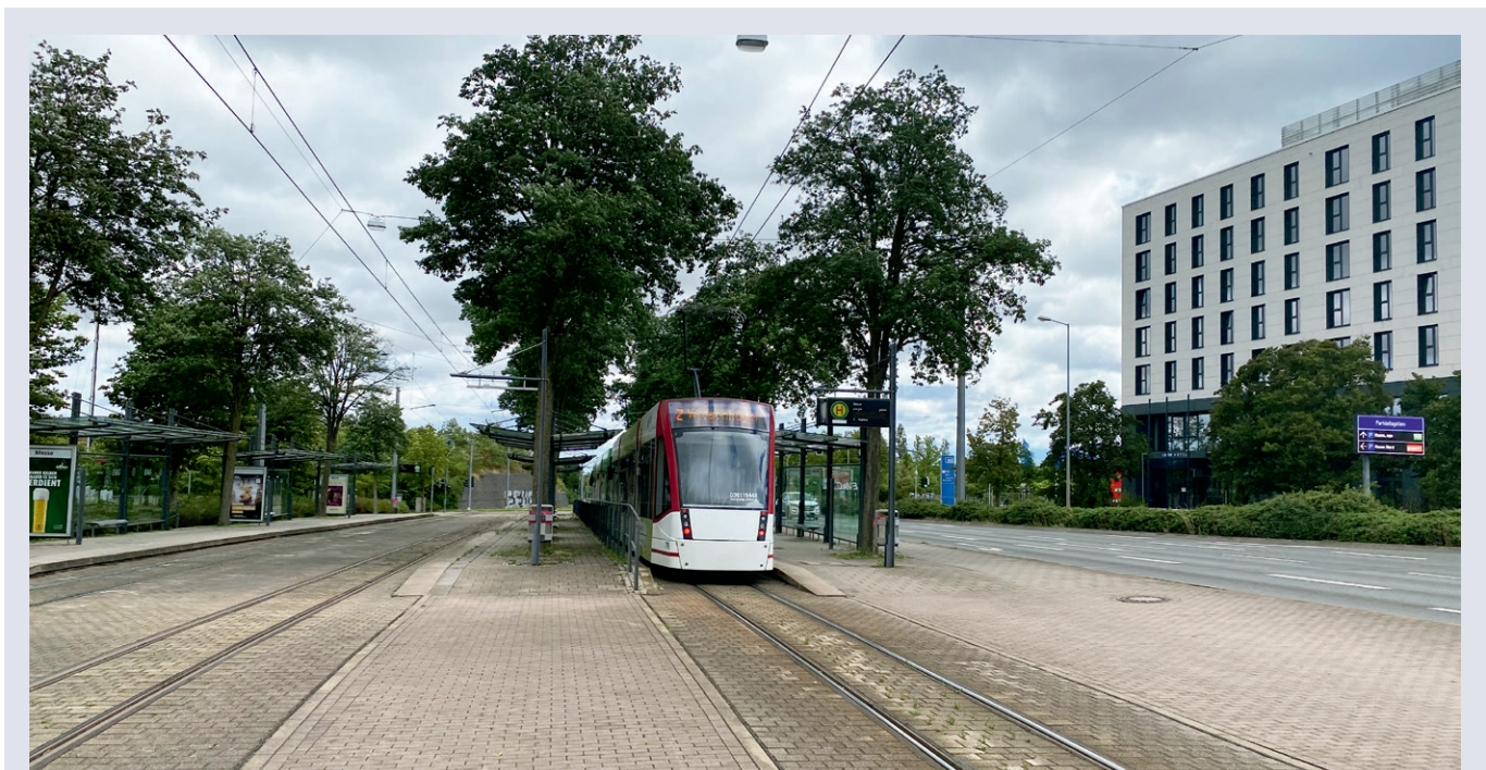
Bei der Neuplanung der Stadtbahntrasse zur Messe Erfurt, die parallel neben einer bestehenden Straße errichtet wurde, konnte die Haltestelle Messe mit zwei Bahnsteigen Richtung Stadt ausgestattet werden, um die großen Fahrgastzahlen nach Veranstaltungen schneller zu bewältigen. Die Haltestelle wurde mit Großbäumen ausgestattet.
