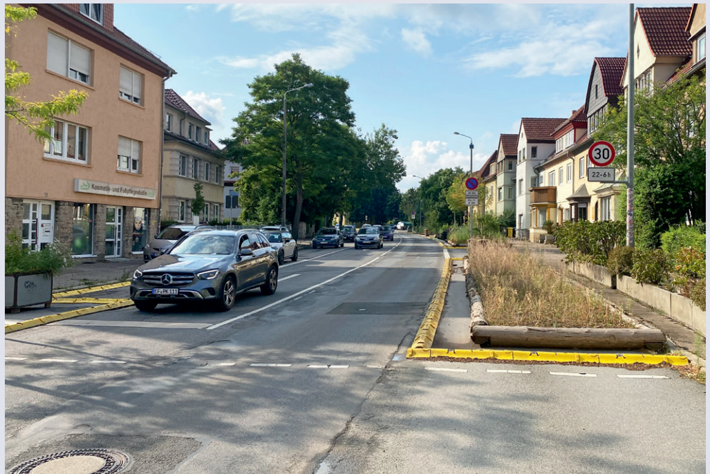
Ein ehemals vierstreifiger Wohngebietszubringer wird auf zwei Fahrstreifen zurückgebaut. Die jeweils äußeren Fahrstreifen werden umgenutzt.
