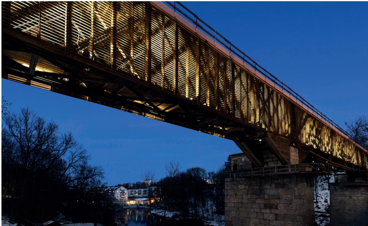
Nach dem Wiedereinbau der Brückenteile wurde der neu entwickelte Witterungsschutz aus schrägen Lärchenholz-Lamellen an der Fachwerkkonstruktion und das neue Geländer inklusive Beleuchtung im Handlauf angebracht sowie der Gussasphaltbelag eingebaut.
